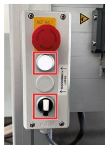
Abb. 27 BEDIENELEMENT MIT NOT-HALT- UND QUITTIERUNGSTASTER
